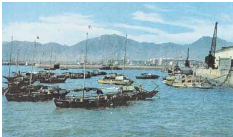
●油麻地避風塘的堤壩，約 1960 年。
